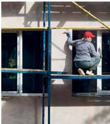
Замена окон снизит потери тепла примерно на 10%.
